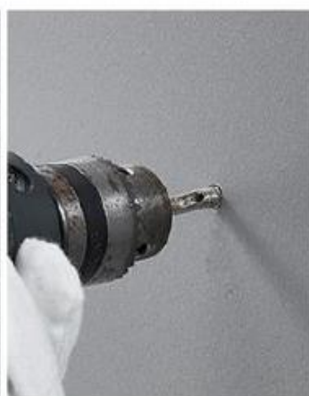
2.用8MM钻头打孔
